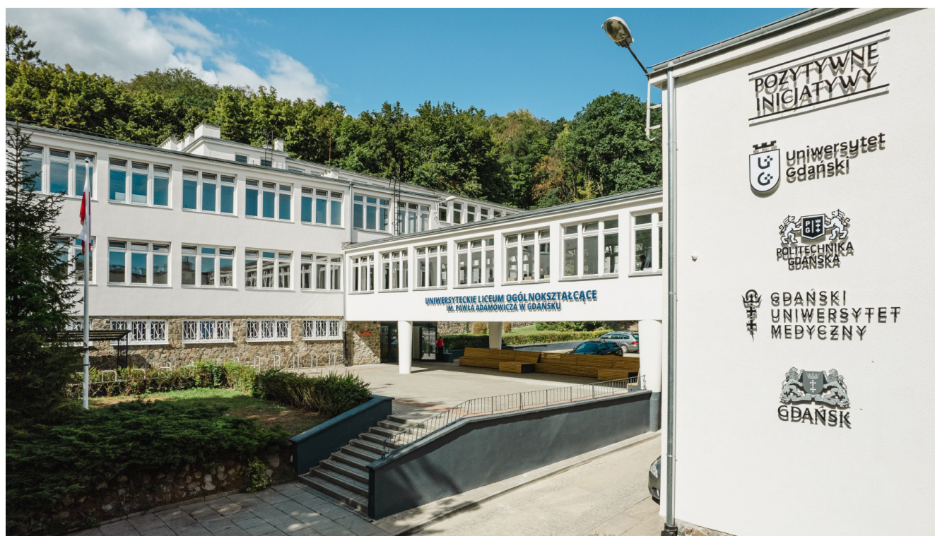
Budynek ULO po remoncie w 2022 roku
