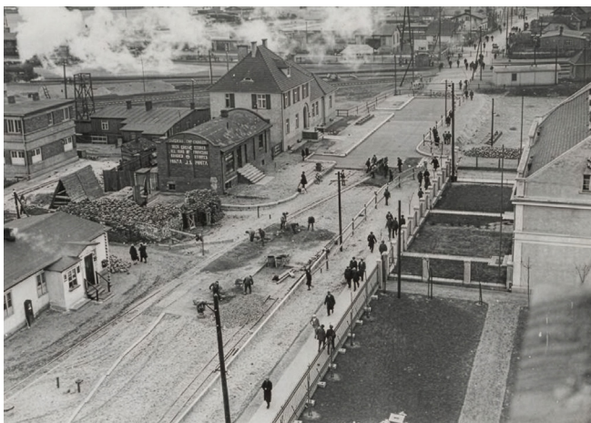
Ulica Centralna (dzisiejsza Chrzanowskiego) łącząca port z miastem w budowie
